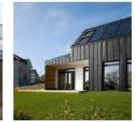
Maison Air et Lumiere, France
